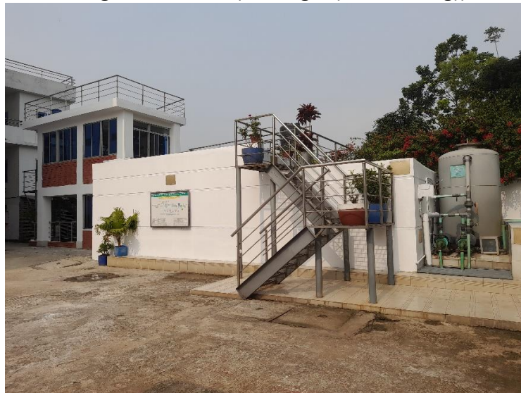
(Buiding-4 (ETP Building)).
