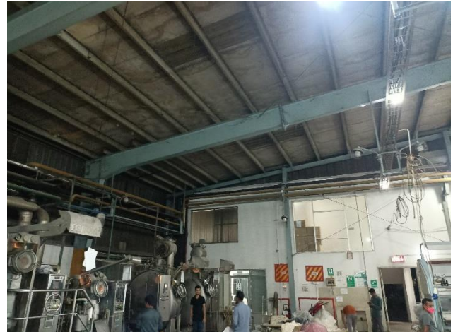
No compression strut on edge
