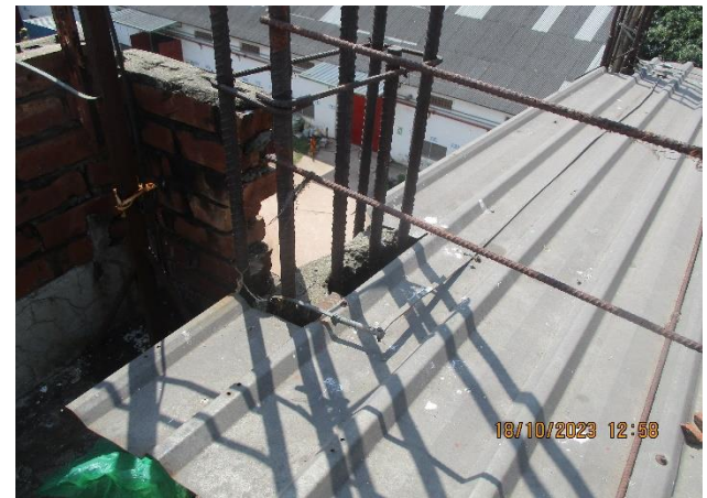
Columns on site
