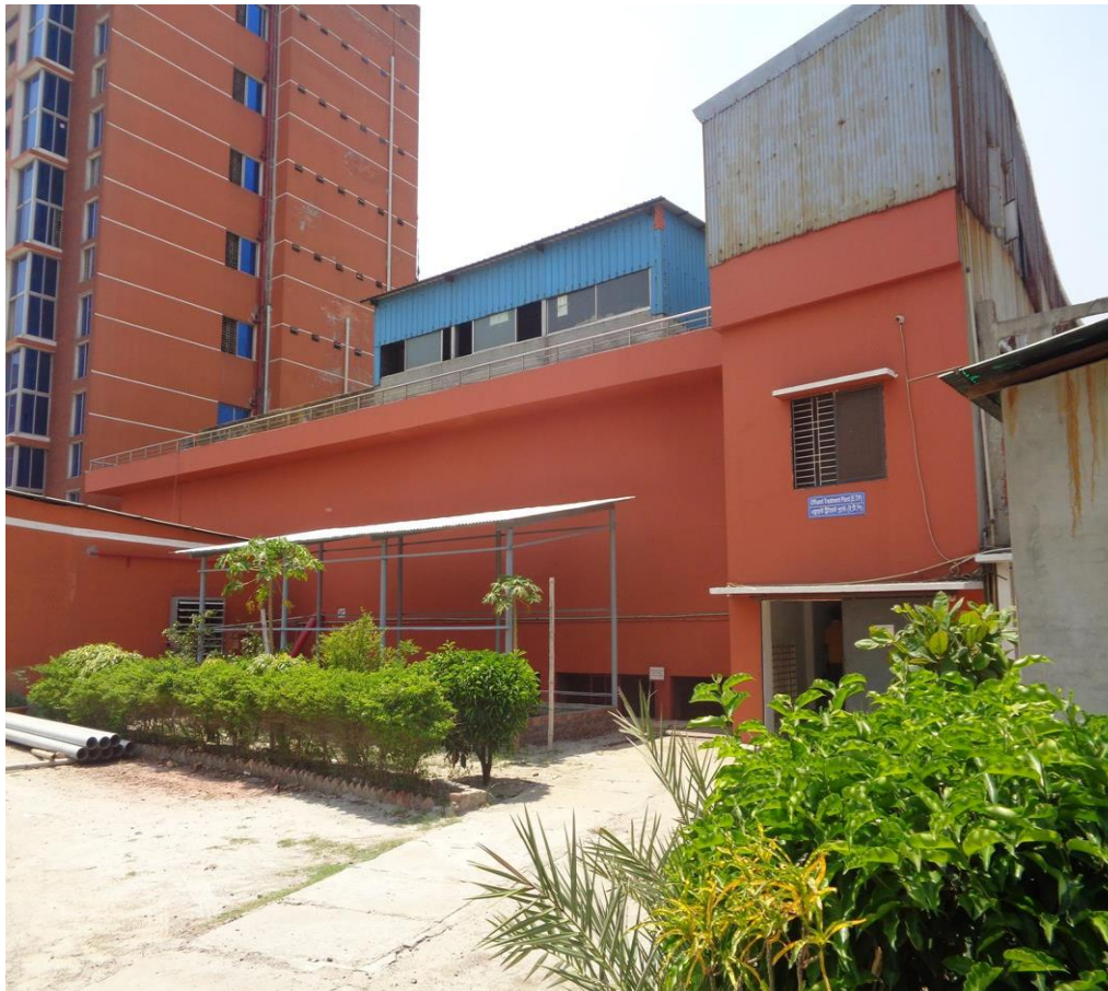
Effluent Treatment Plant (ETP)
