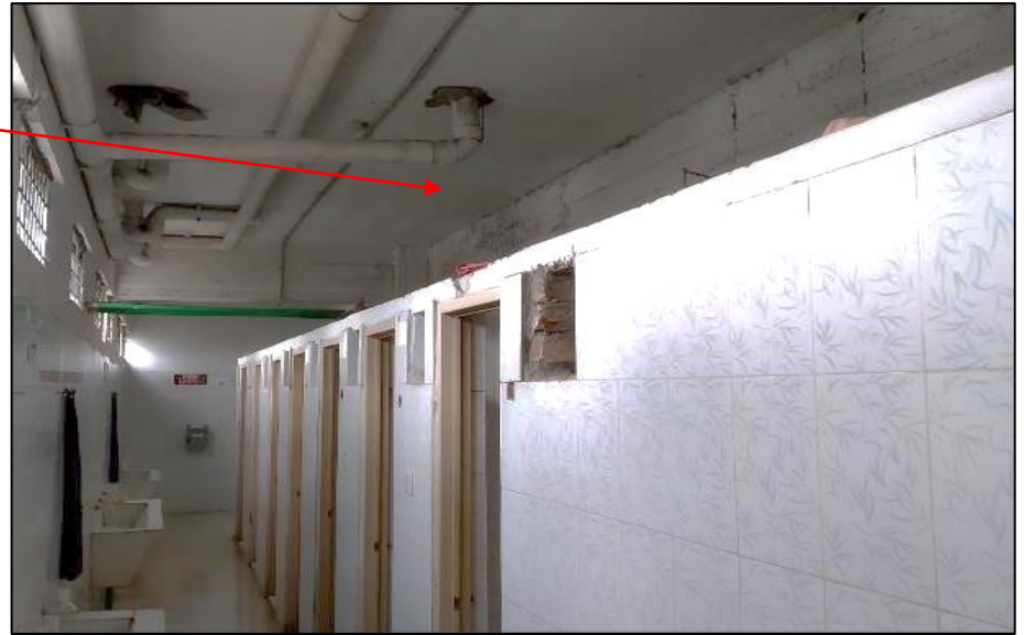
Edge beam on Toilet area
