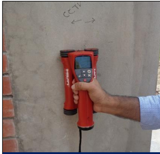
(Building-6): Rebar Scan
