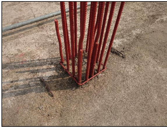
On site column C10 ( 15"x15")
