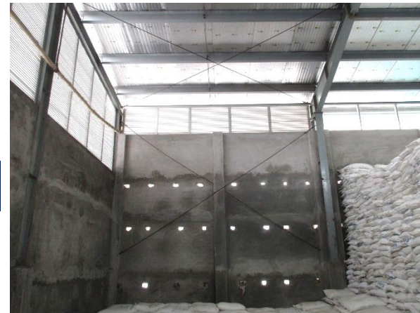
Vertical (wall) bracing
